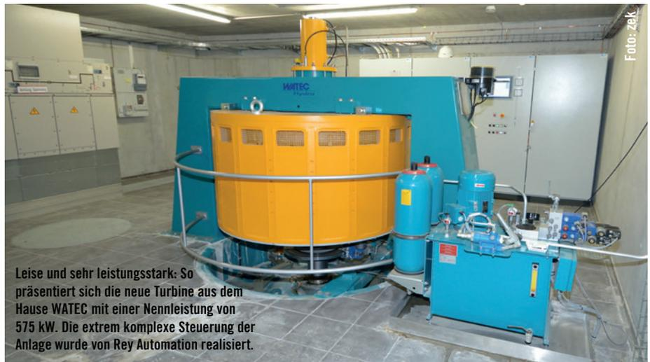
Leise und sehr leistungsstark: So präsentiert sich die neue Turbine aus dem Hause WATEC mit einer Nennleistung von 575 kW. Die extrem komplexe Steuerung der Anlage wurde von Rey Automation realisiert.
