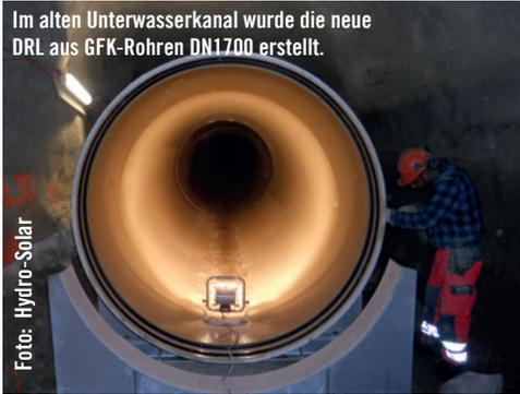
Im alten Unterwasserkanal wurde die neue DRL aus GFK-Rohren DN1700 erstellt.
